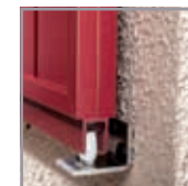
Guidage ponctuel bas fixé en façade
