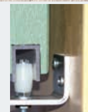
Guidage bas, ponctuel, olive sur équerre (volet bois)
