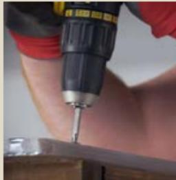
Si vous utilisez des profilés en polycarbonate, la fixation se fera directement dans les plaques, avec des vis, directement dans les chevrons.
