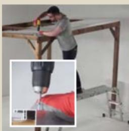
**1-** Les plaques sont à poser avec des profilés aluminium. Commencez la pose par un profilé de rive, en le vissant sur la charpente.
