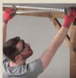
La finition des chants périphériques (en haut, en bas et sur les côtés) des plaques est réalisée avec des profilés d'obturation en U.
