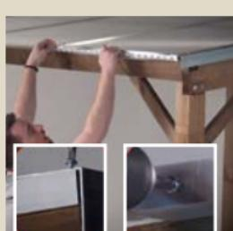
**6-** Passez maintenant à l'installation des profilés d'extrémité ainsi que des embouts afin d'assurer une finition soignée.
