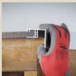
**2-** Engagez la première plaque jusqu'à ce qu'elle vienne en butée dans le fond du profilé pour permettre le mouvement thermique.
