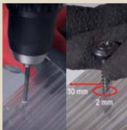
Des trous de 4 mm supérieurs au diamètre de la fixation utilisée doivent être réalisés. Les perçages ne doivent pas être réalisés à moins de 3 cm du bord de la plaque.
