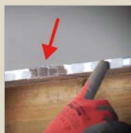
Des profilés en H sont utilisés en fixation intermédiaire entre les plaques. La jonction entre les profilés H et U et les plaques ONDUCLAIR® PCMW doit être scellée avec un **silicone incolore résistant aux UV**.
