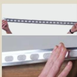
**5-** Installez les obturateurs haut (ruban plein) et bas de pente (micro perforé) qui permettront la bonne ventilation des plaques.
