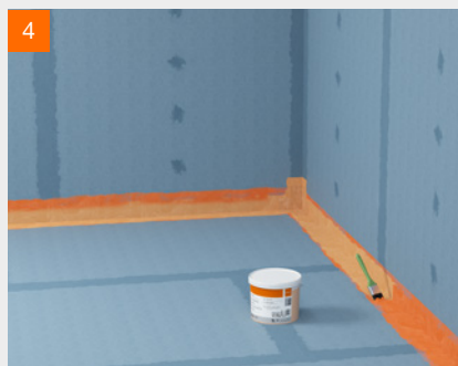
Appliquer la seconde couche de SPEC. La bande de pontage est ainsi marouflée entre les deux couches de SPEC
