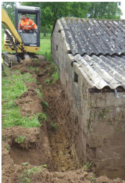
FIGURE N°3 : DEGAGEMENT DES FONDATIONS A L'AIDE D'UNE PELLE MECANIQUE ET FINITIONS A LA PELLE A MAIN
