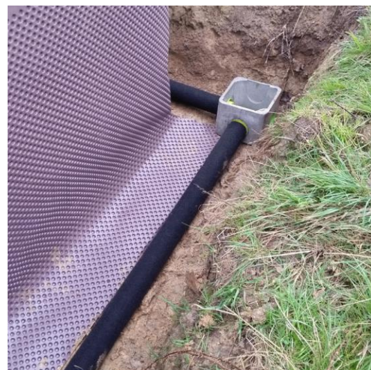
FIGURE N°18 : CHANGEMENT DE DIRECTION AVEC UNE BOITE D'INSPECTION
