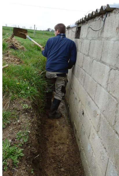
FIGURE N°3 : DEGAGEMENT DES FONDATIONS A L'AIDE D'UNE PELLE MECANIQUE ET FINITIONS A LA PELLE A MAIN
