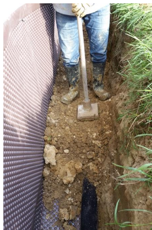
FIGURE N°26 : DAMMAGE MANUEL DES COUCHES DE REMBLAIS
