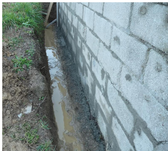
FIGURE N°5 : REJOINTOIEMENT DES PAREMENTS DES FONDATIONS
