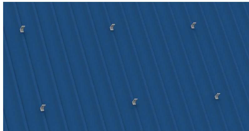
Après avoir défini la position, installez le pied en L sur le toit puis serrez fermement à l'aide de la vis auto-tarodeuse fournie.
